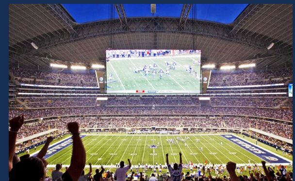
AT&T STADIUM, DALLAS TEXAS, USA
